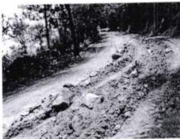
Proceso de estabilización con cemento
