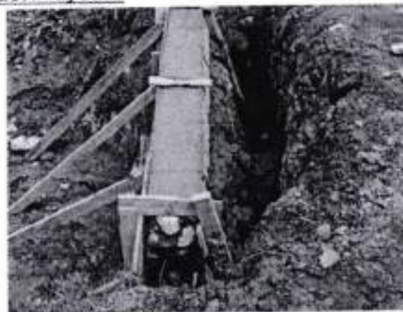
Construcción Finalizada de cabezal de mampostería
