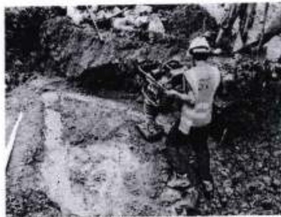
Relleño y compactado con material del sitio sobre tubería de desagüe
