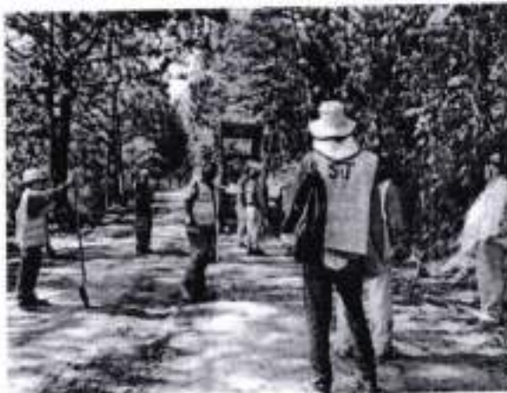
Preparando terreno para estabilizar a nivel de sub rasante antes de estabilización con cemento en estaciones 6+560 a la 6+660 el 29 julio del 2025
